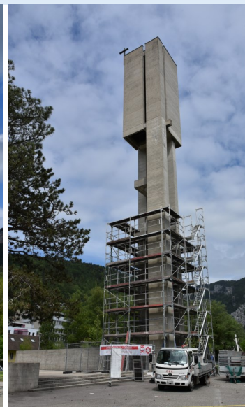
Les travaux de réfection du clocher ont débuté
