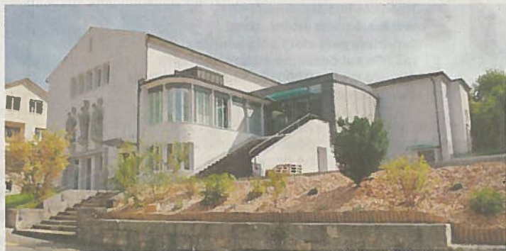
La bâtisse de 1939 sera célébrée comme il se doit samedi. M. BASSIN
